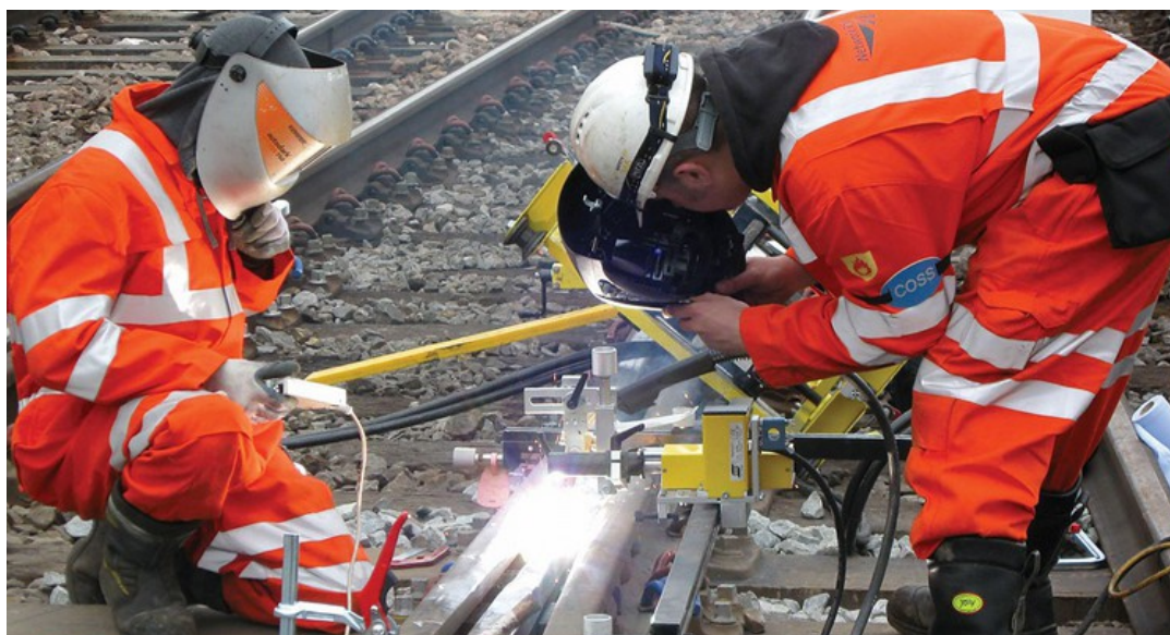
Een wissel van een spoor is een typisch voorbeeld van impactslijtage
